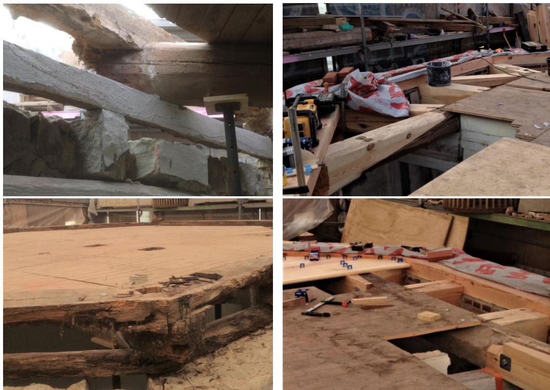
september 2016 - Det rådne bjælkelag i rem og brodæk bliver udskiftet med nyt tømmer - december 2016
